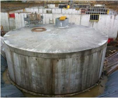
**Der Eisspeicher mit 89 m<sup>3</sup> Inhalt wurde im Rahmen der Aushub- und Untergrucharbeiten erstellt, was eine kostengünstige Realisierung ermöglicht.**
