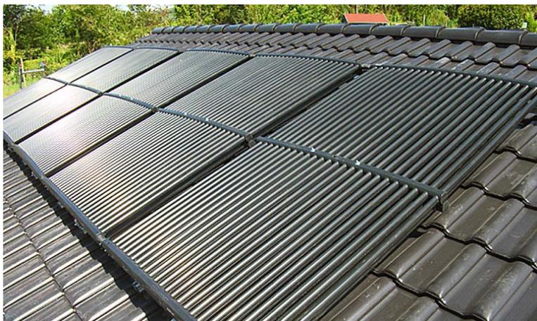
**Für die Erwärmung des Speichers können unterschiedliche Energiequellen genutzt werden. In Dornach setzt man unverglaste Kollektoren zum Gewinn von Sonnenenergie ein.**
